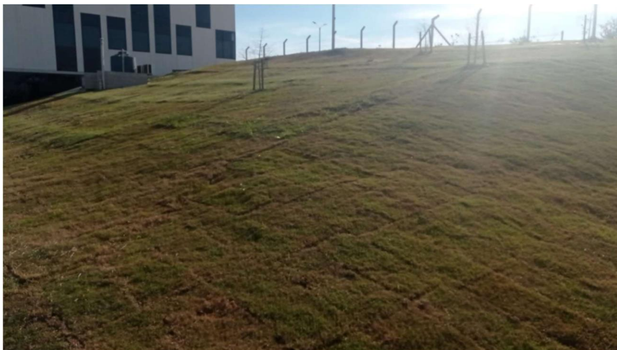
Foto del 14 de mayo de 2021 frente a Nave B
